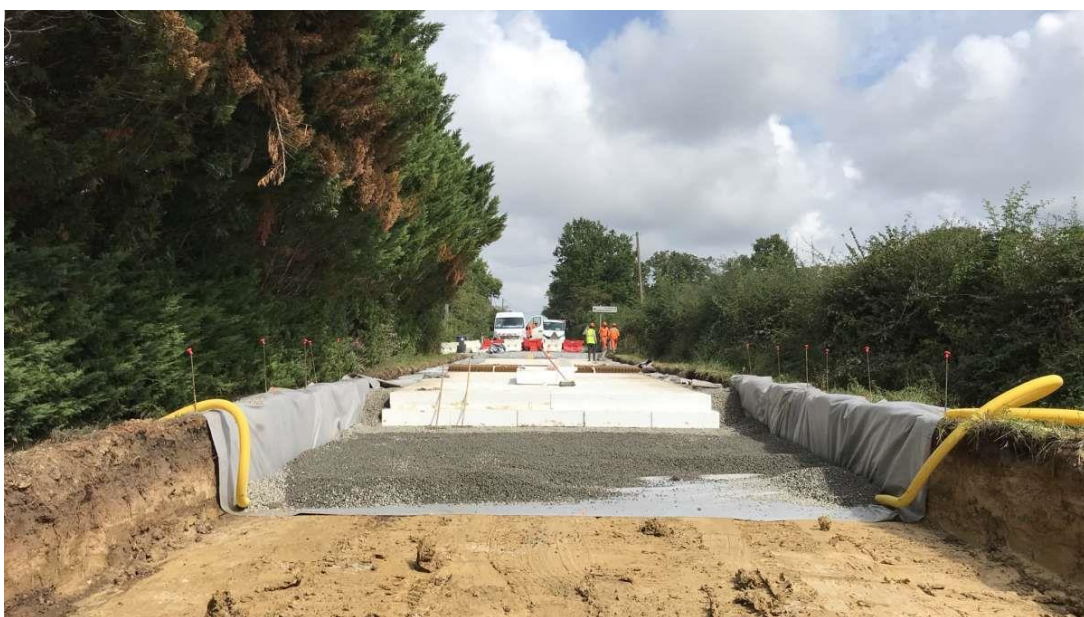
Figure 1 .21 Route exposée au retrait-gonflement des sols (Cerema 2021)
