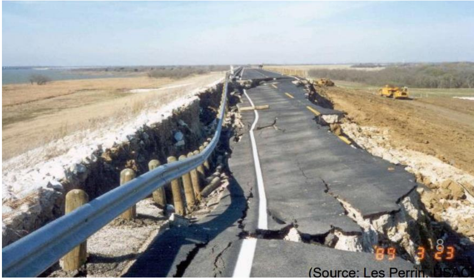
Figure 1.18 Crête du barrage Joe Pool (Puppala 2021)
