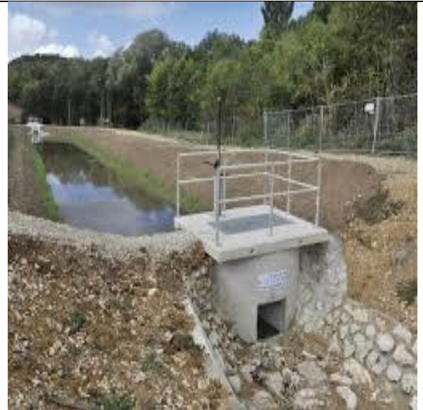
Figure IV.13 : Batardeau en Béton
