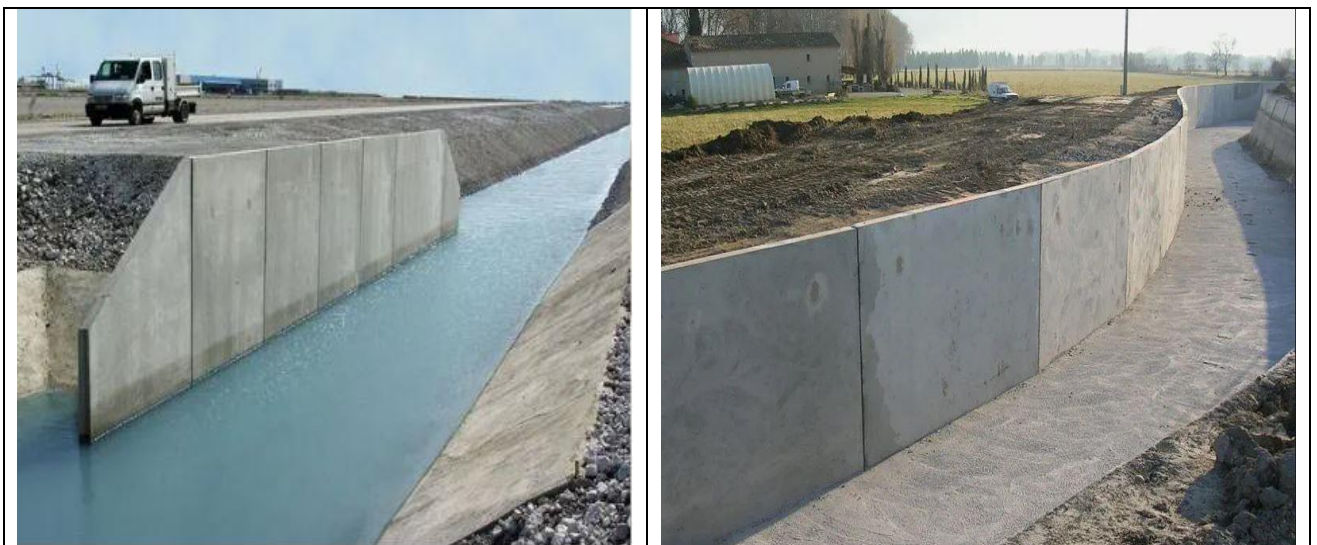
Figure IV.10 : Mur soutènement en béton
