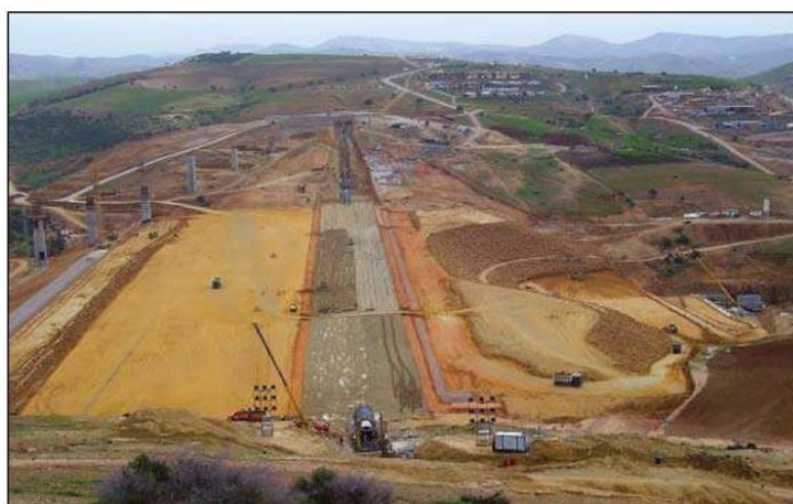
Figure ( 2.10 ): Noyau centrale d'argile, cas du barrage de kramis.
