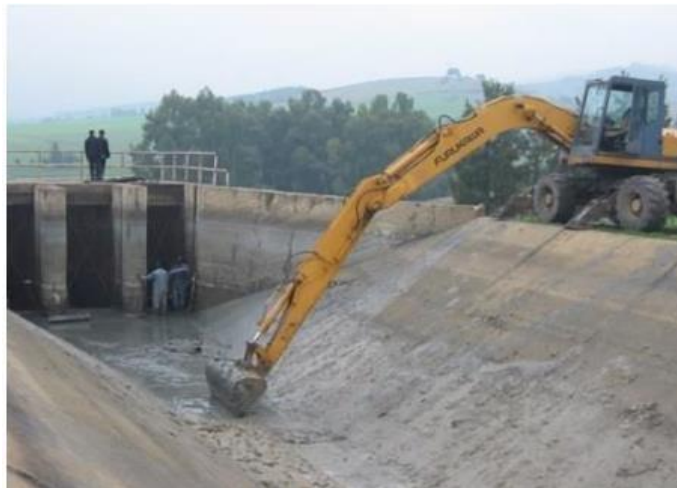
Figure ( 1.6 ) : Curage d'un canal par les moyens mécaniques Remini et al.,( 2011) .
