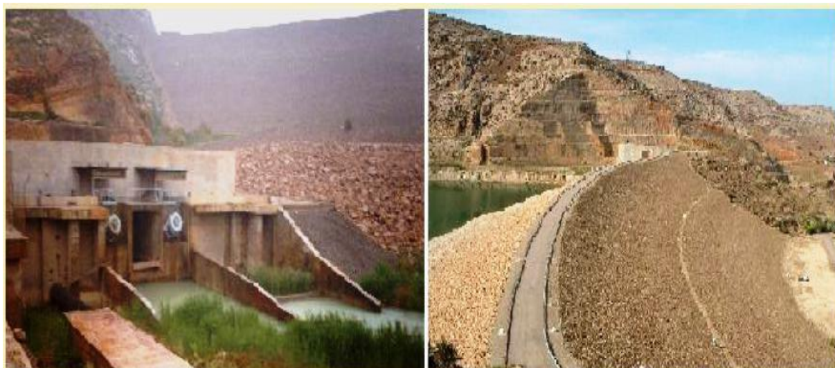
Figure (3.11) : Vue générale de la digue du barrage de Gargar. (ANBT, 2004)
