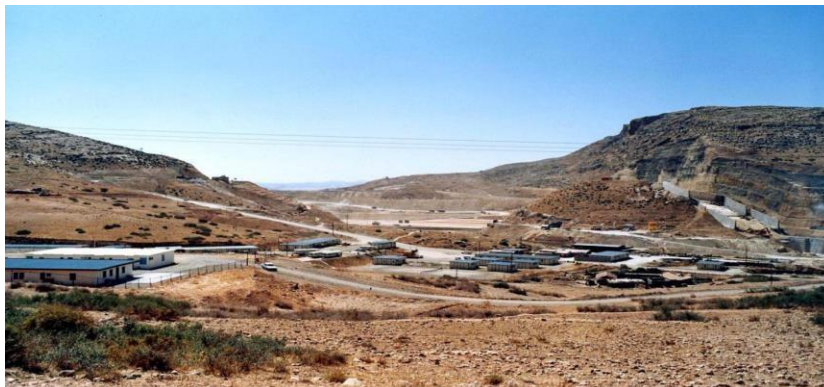
Figure (3.4) : Début de travaux de réalisation du barrage de Gargar. (ANBT, 2004)
