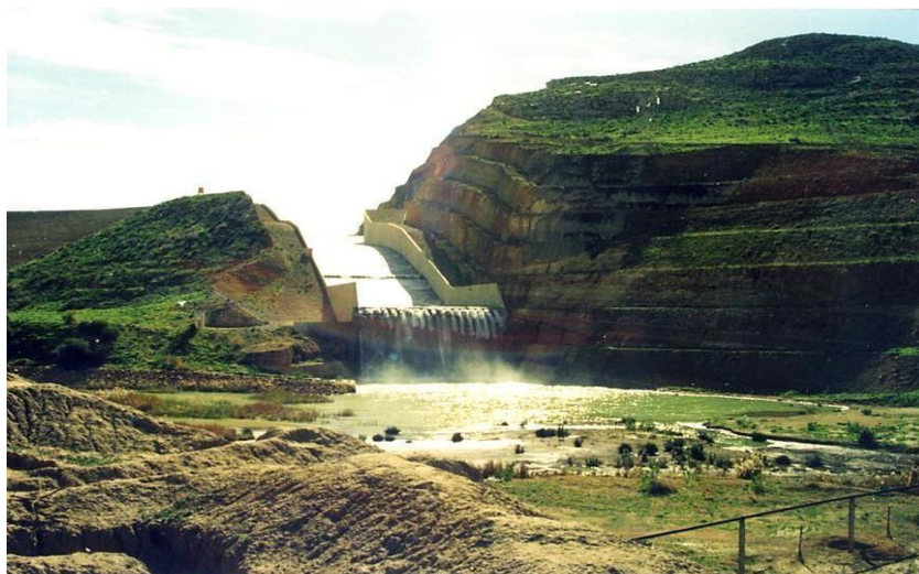
Figure (3.8) : Evacuateur de crue du barrage Gargar. (ANBT, 2004)
