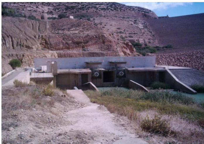
Figure (3.10) : La vidange de fond et la prise d'eau du barrage Gargar. (ANBT, 2004)
