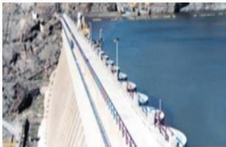
Figure (2.1): Barrage de Ksob surélevé en 1977. (ANBT, 2004).
