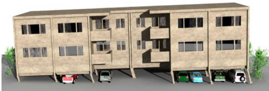
Figure 1.1 : Bâtiments avec étage souple, RDC (Ben Lachhab 2023)
