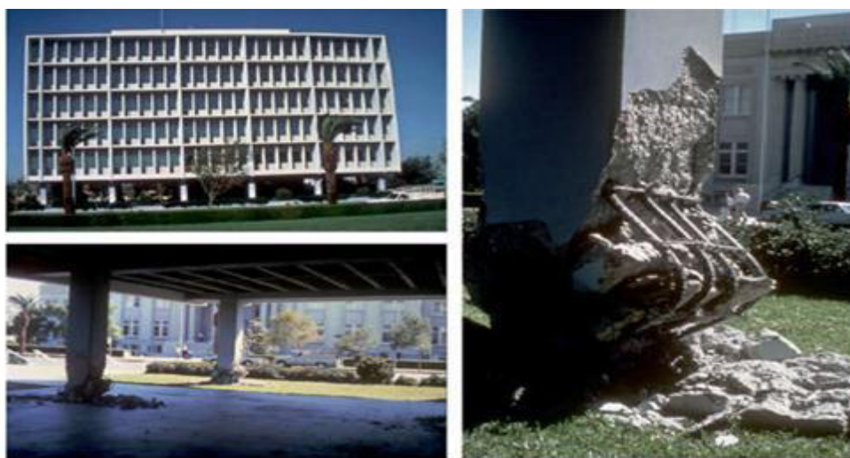
Figure 1.7 : Apparence de l'étage souple à la construction de Services Imperial Conty
