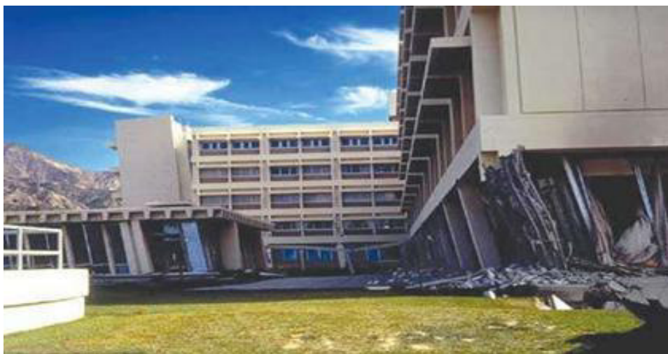
Figure 1.6 : hôpital Olive après le séisme de San Fernando, dommages typiques dus à la discontinuité du mur.
