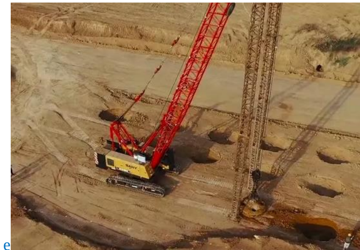
Fig 1.2 : Compactage dynamique profond.
