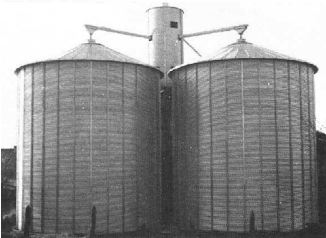
Figure I.4 : silo à grain.[9]
