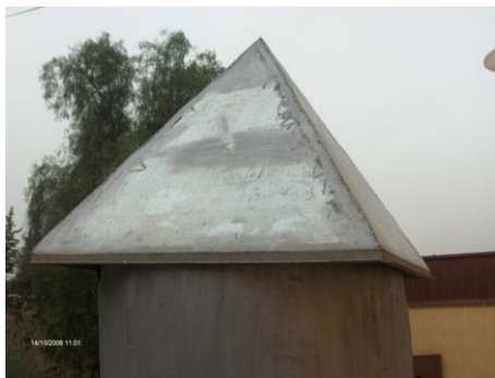
Figure IV.3 : Chapeau du silo
