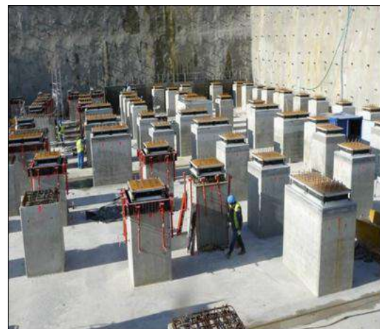
Figure I- 13: Schéma du réacteur expérimental Jules Horowitz (Cadarache, France) avec ses appuis parasismiques visibles dans la partie inférieure (Hadji. & Ouakil, 2019)
