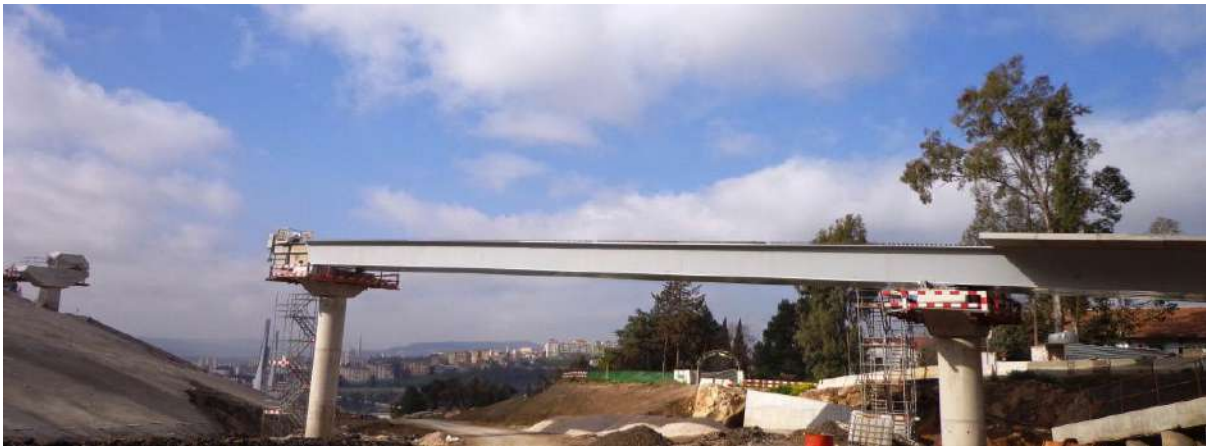
Figure I- 32 : Passage supérieur de Constantine (Algérie) (Mageba, Constantine Overpass (Algeria), 2014)
