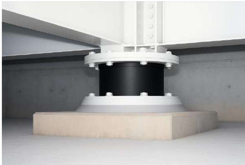
Figure I- 17: Isolateur de caoutchouc à fort amortissement du bâtiment de réserve d'urgence de County Los Angeles (Creator, Aiken, Ian D. James M. Kelly Collection : NM0034. Courtesy of NISEE)
