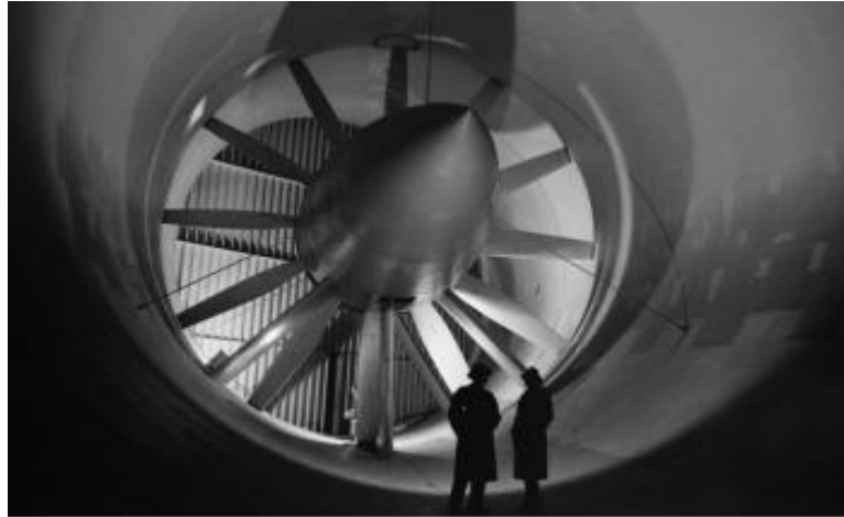
Figure I.7 Rotor de la soufflerie du centre de recherche Glenn, NASA. Cleveland, OH.
