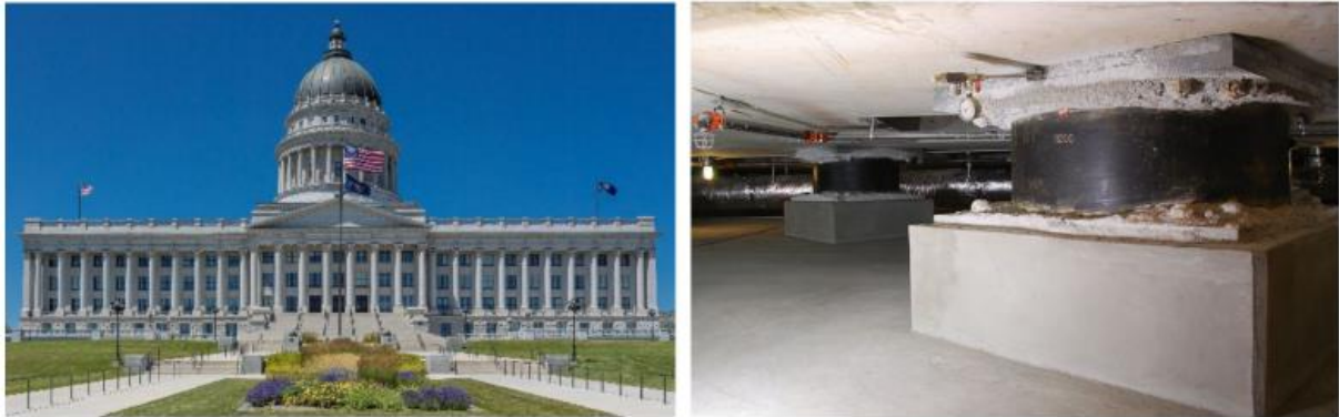
Figure 1.8- Bâtiment du Capitole de l'État de l'Utah et les dispositifs d'amortissement sismique (isolateurs de base).
