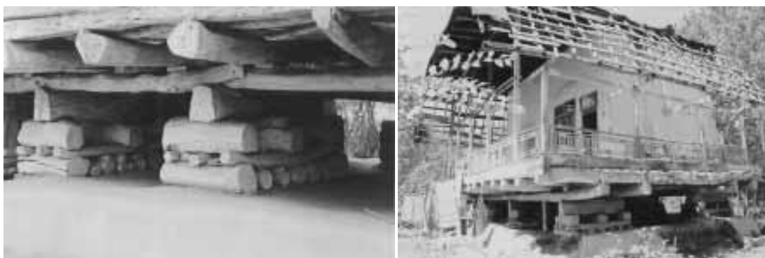
Figure. 1.12- Utilisation de morceaux de bois entre le sol et les murs porteurs des maisons traditionnelles de Lahijan, au nord de l'Iran,
