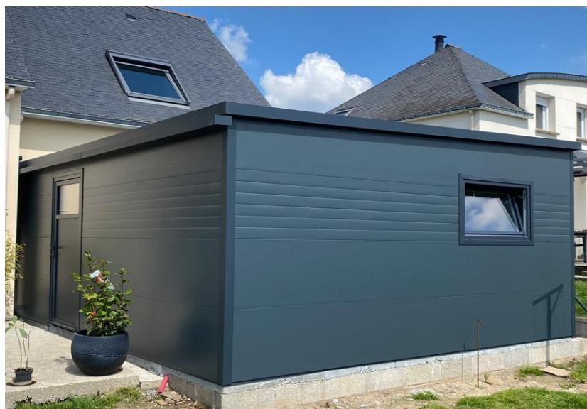
Figure III.3 : parking fermé en panneau sandwich
