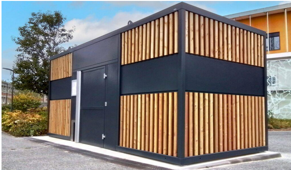
Figure III.4 : parking ferme en bois
