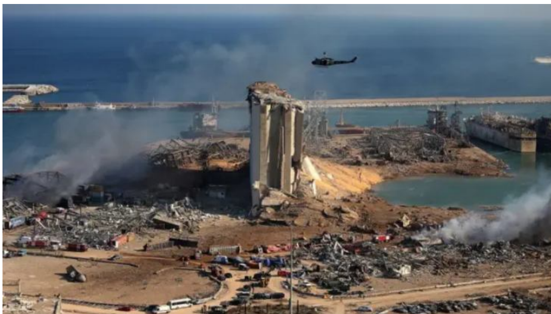
Figure 0-4 Explosion du port de Beyrouth, Liban, en 2020 [4]
