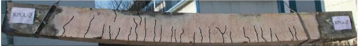
Figure II-30 Poutres testées par Hou, Ren [98] après exposition au feu
