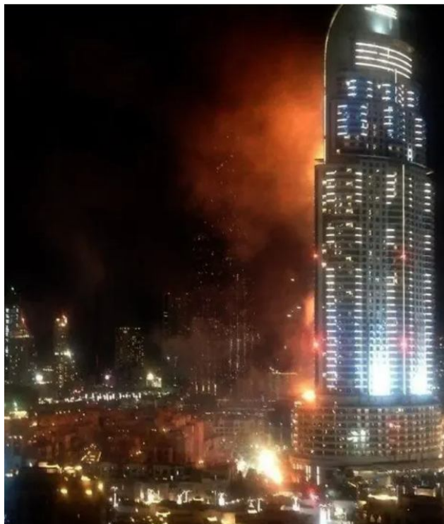
Figure 0-1 Incendie du complexe d'appartements Downtown à Dubaï en 2016 [1]
