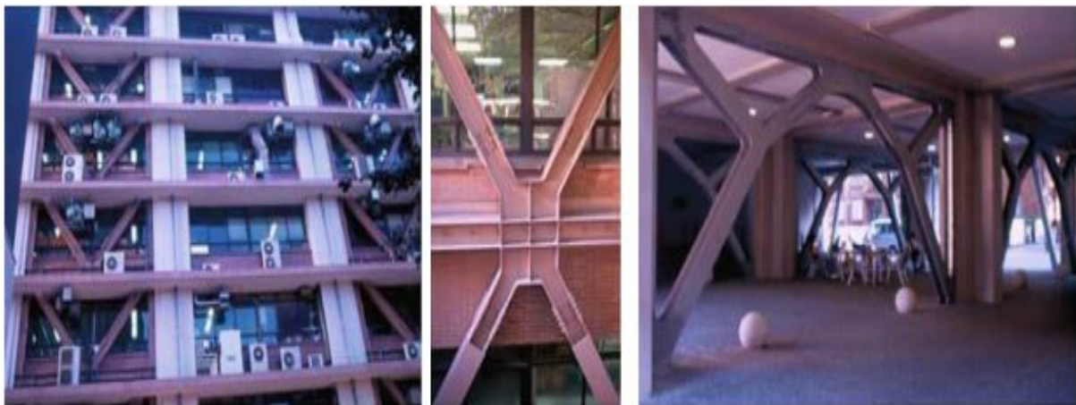
Figure 1.6 : Renforcement des structures par l'ajout des contreventements métalliques (Fardis 2009).
