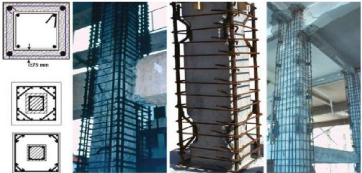
Figure 1.3 : Renforcement par chemisage en béton (Khuong 2015).
