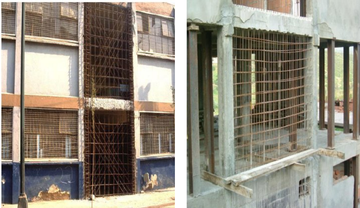
Figure 1.5 : Renforcement des structures par l'ajout des voiles en béton armé.
