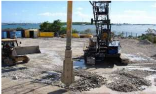
Fig. 1.6. Vibroflotation ou vibrocompaction ( http://btscm.fr/ )
