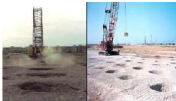
Fig. 1.5. Compactage dynamique
