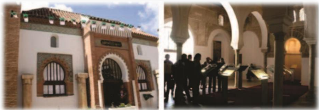
Figure 48: La mosquée de Sidi Belahcen après restauratio
