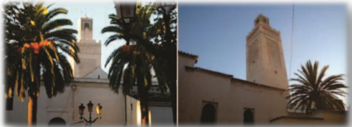
Figure 47: La restauration de la Grande Mosquée de Tlemcen
