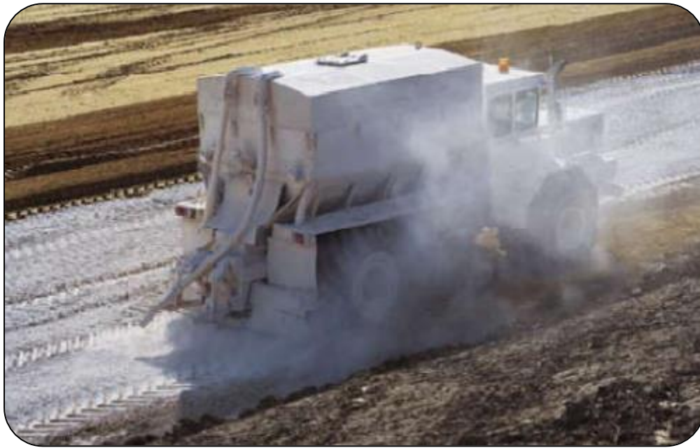
Figure 1.7 : Incorporation de la chaux ou du ciment à l'aide d'un épandeur (Tayebi et Triki, 2019).
