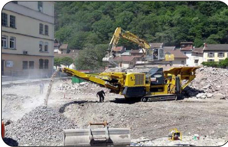
Figure 2.2 : Broyage du béton (Oumeddour, 2020).
