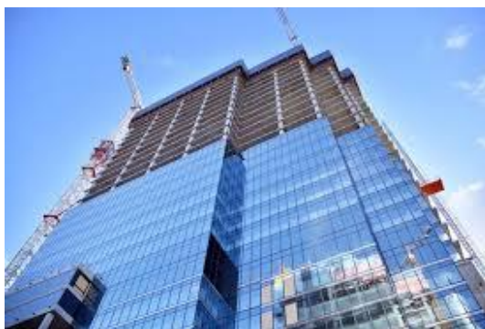
Figure1.1: Immeubles de grande hauteur modernes en construction[2]
