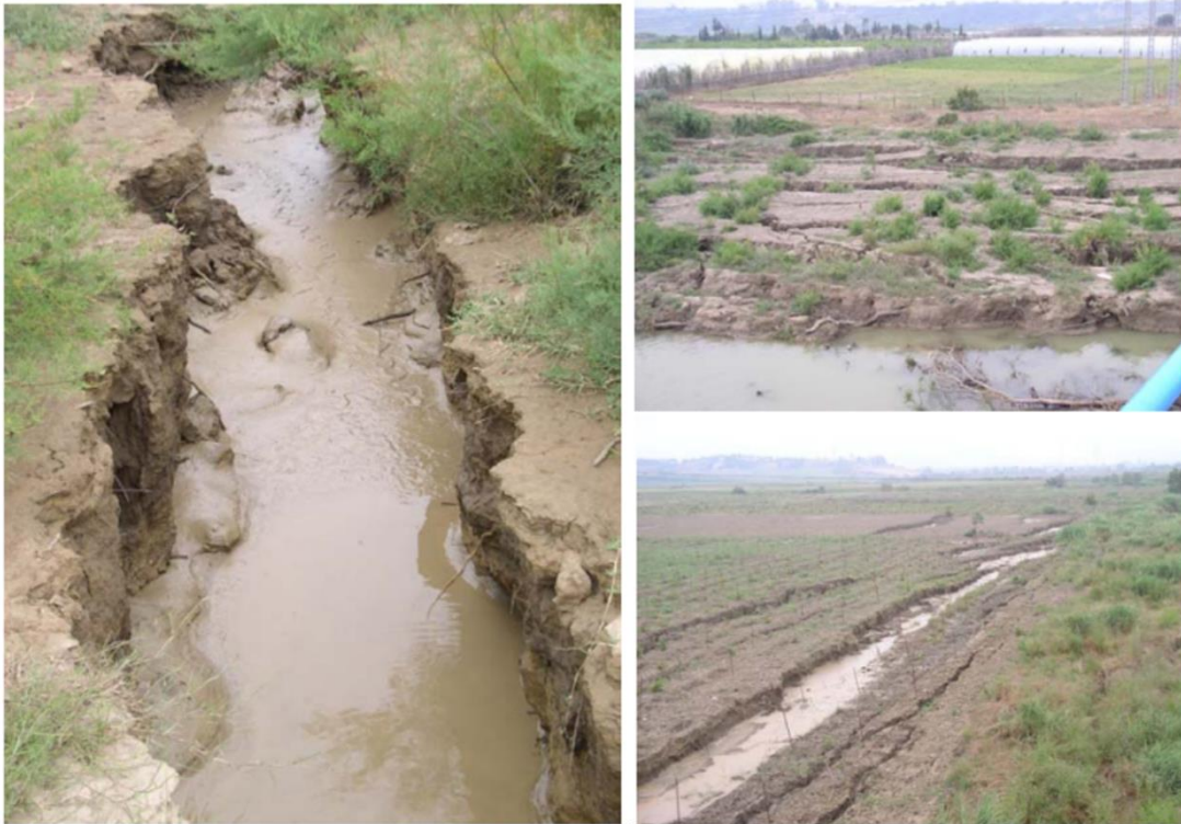
Figure IV.2. Liquéfaction des sols à proximité de la rivière Isser, Zemmouri-Boumerdes (AFPS 2003).
