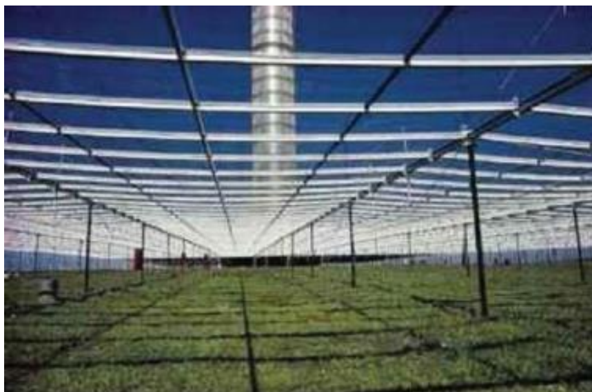
Figure I.1. Vue intérieure du collecteur de cheminée solaire [1]
