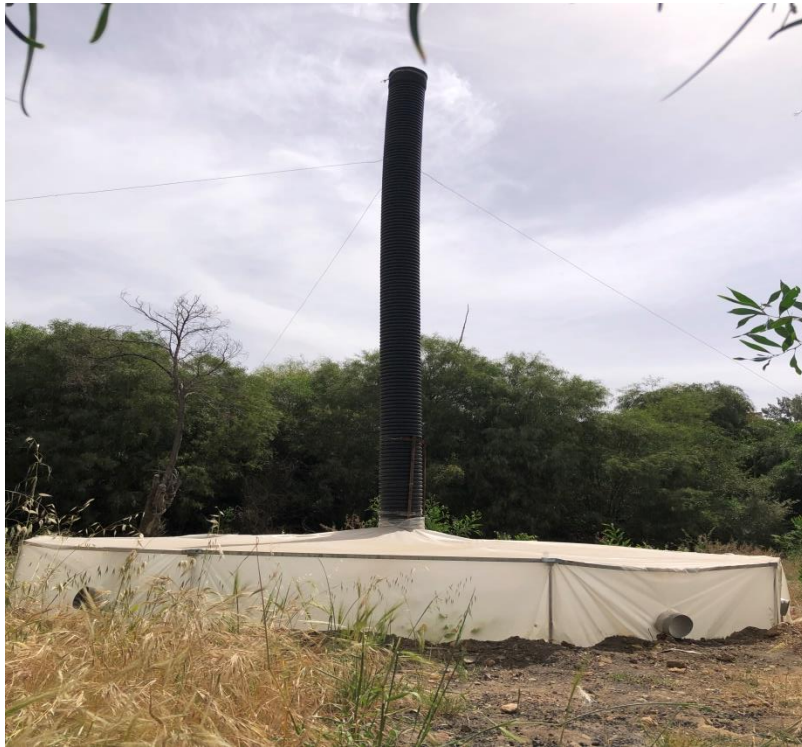
Figure III.5. Une photo du montage "CCS" expérimentale à Chlef
