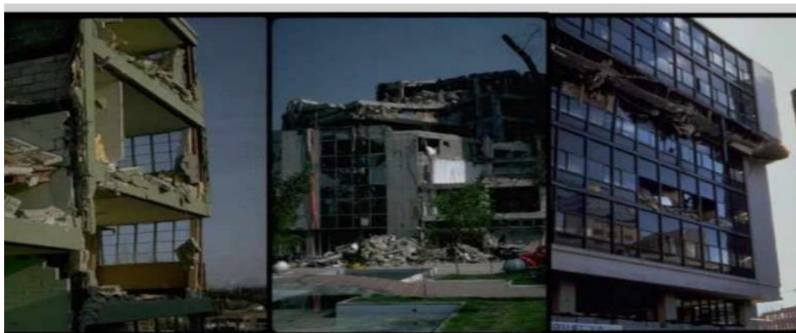
Figure I.2 : Désolidarisation des façades, destruction des étages supérieurs [1]
