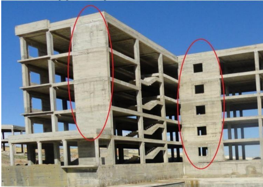
Figure I.13 : bâtiment à des voiles en béton armé [7]
