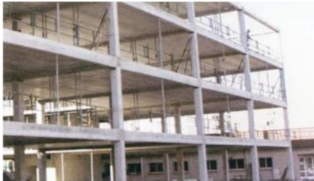
Figure I.9: Structure contreventé par portique [6]
