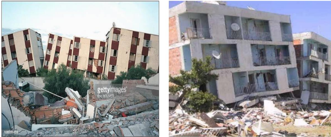
Figure 1.2 : Séisme de Boumerdès en 2003 en Algérie [5]
