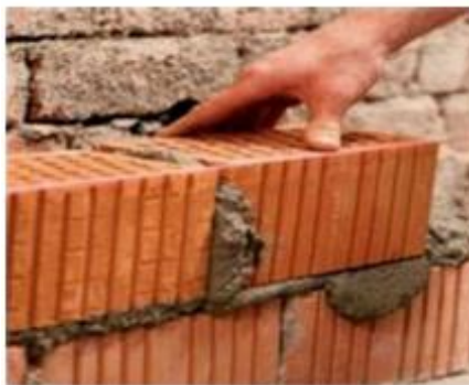
Figure 2. 2. Le hourdage de maçonnerie.
