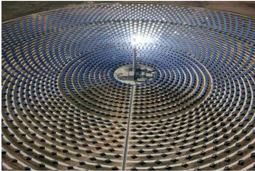
Figure 1.5 : Centrale solaire thermodynamique
