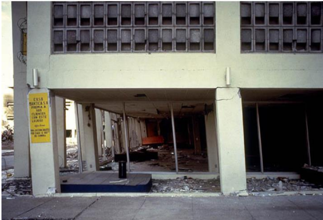
Figure I.24 : Poutres plus résistantes que les poteaux http://www.structureparasismic.com/PdvRps2000.html .
