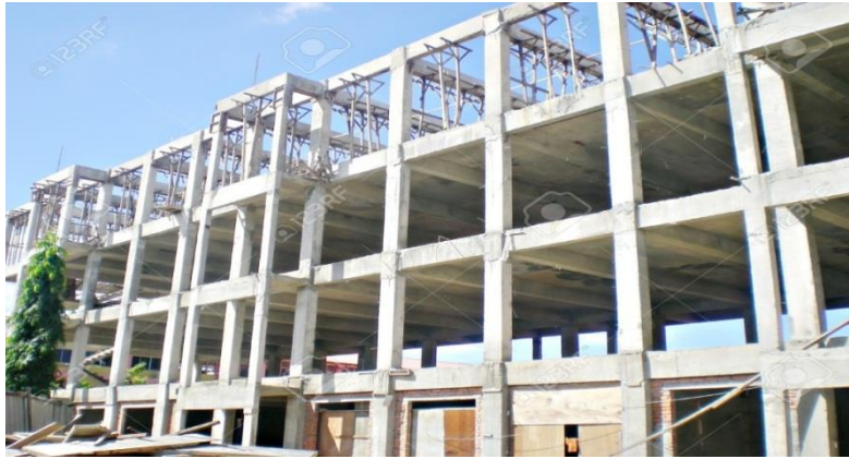
Figure 1.1 : Structure en portiques.
