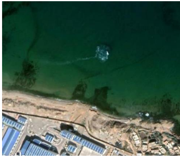
Figure III-1: Rejet de saumure de la station de dessalement de Mainis
