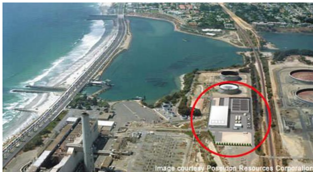
Figure IV-3 : Station de Dessalement de Carlsbad, Californie, États-Unis
