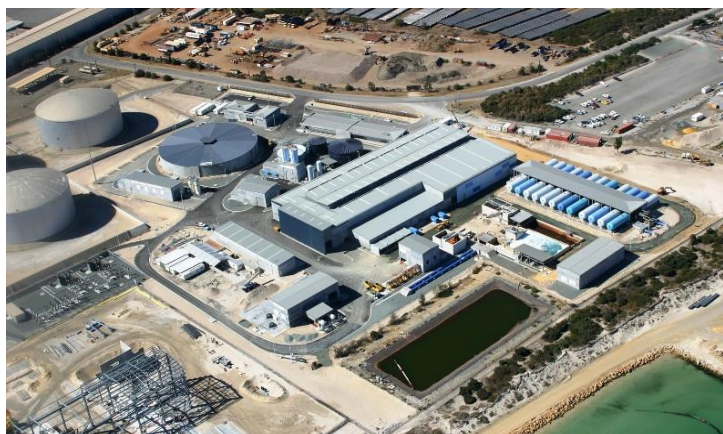
Figure IV-1 : Station de dessalement de Perth, Australie
