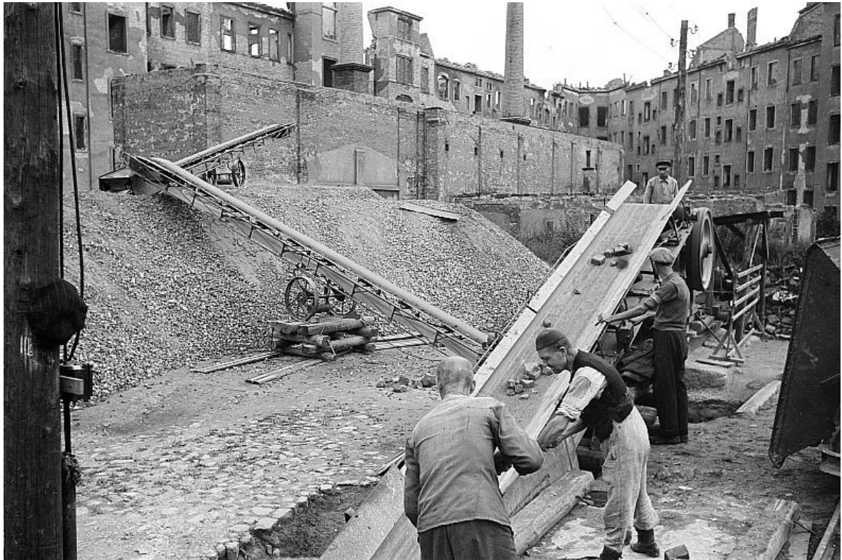
Figure 1.2. Chaîne de préparation des granulats recyclés.
