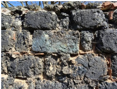
Figure 2.3. Mur construit en Mâchefer
